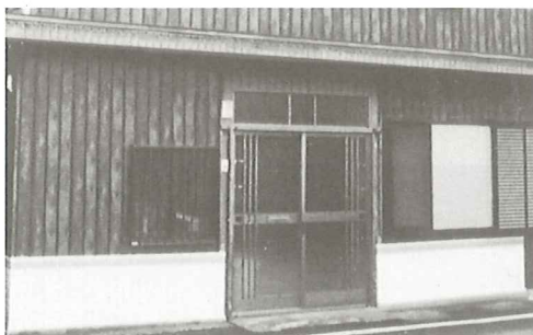
写真25 タイル張壁（西大泊-3）
