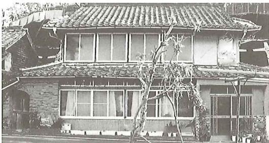
写真22 建物左側に煉瓦壁（東大泊-1）
