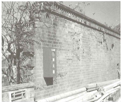
写真27 煉瓦塀（東大泊-1）
