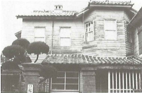
写真17 上げ下げ窓(前方-1)
