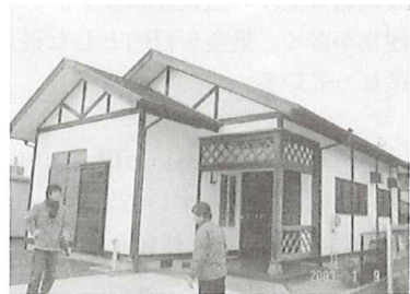
写真19 外観（矢上団地東公民館）
