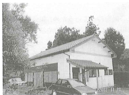
写真17 外観(新田頭公民館)
