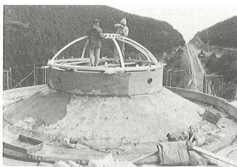
写真-4 ドーム取付け
