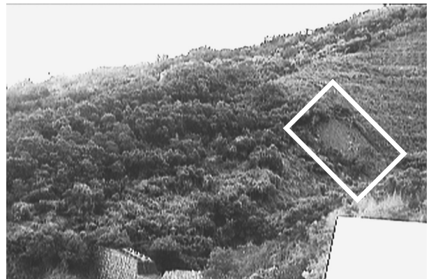
図17 針原地区の現場写真(06年8月19日撮影)
